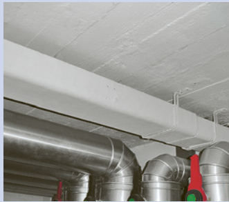
Kabelkanal aus Asbestzement
