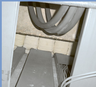
Brandabschottung mit Asbestkissen
