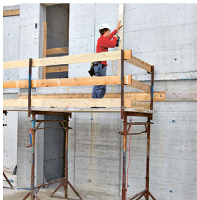
2 Bockgerüst mit korrektem Seitenschutz
