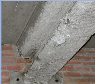
Spritzasbestisolierung
