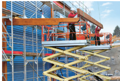
2 Montage von Tragwerken mit Hilfe einer Hebebühne
