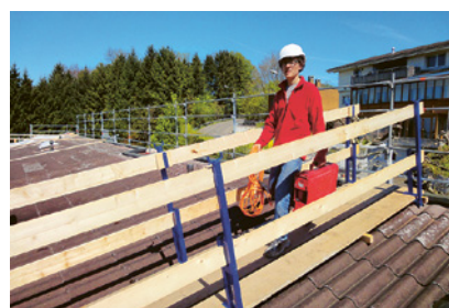
3 Nicht durchbruchssichere Dachflächen: Laufstege einsetzen.
