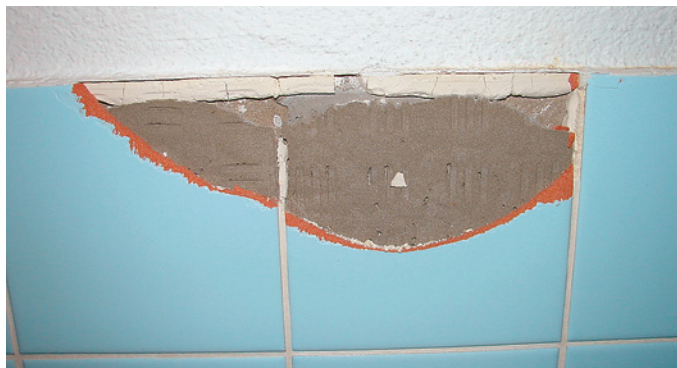
< 1 % Chrysotil-Asbest im Kleber
