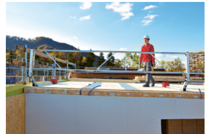
3 Mobiler Seitenschutz für temporäre Absturzstellen an Dachrändern
