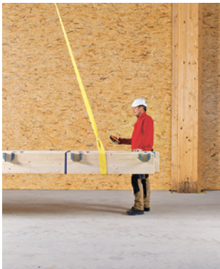
Regel 6 Lasten richtig anschlagen
