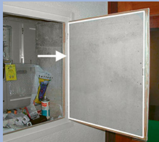
Asbesthaltige Brandschutzplatte
