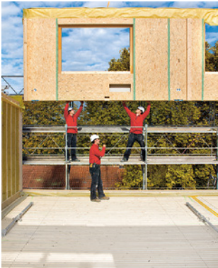
Regel 3 Mit Fassadengerüst arbeiten
