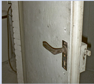
Brandschutztüre mit Asbestzement
