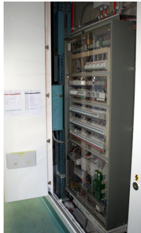
Elektro- / Zählerschrankfronten
